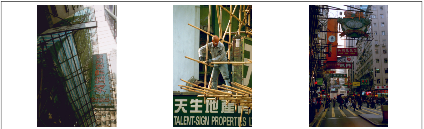
Echaffaudages en bambous et temple au milieu des buildings
