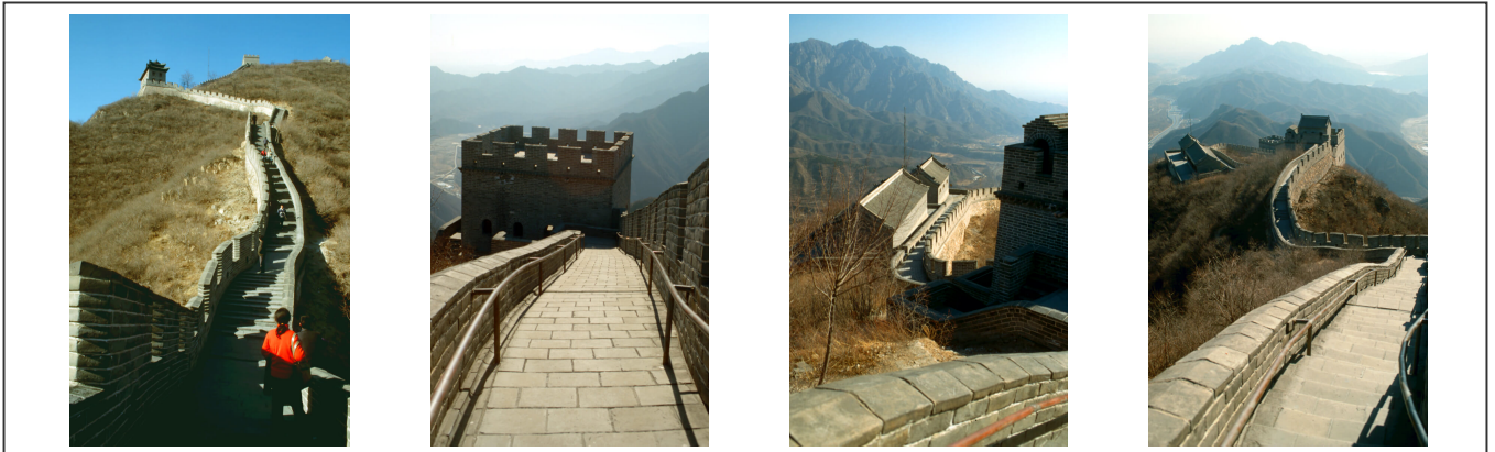
La partie rénovée
